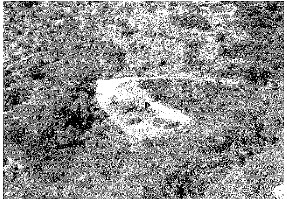
Bassa contra-incendis del Barranc de la Carbonera
